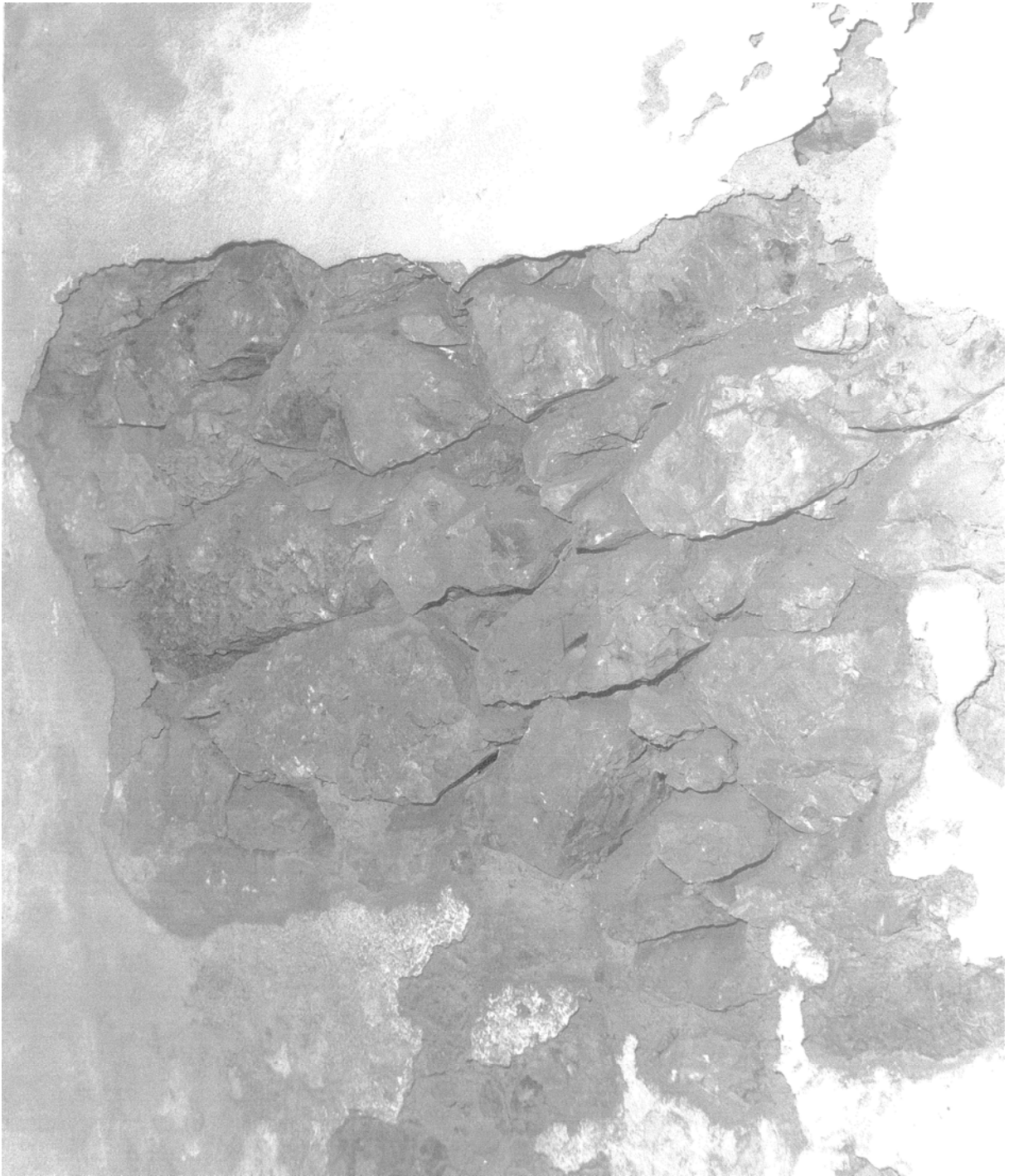
Αποκολλήσεις επιχρίσματος και κονιάματος σε κακής ποιότητας αργολιθοδομή
